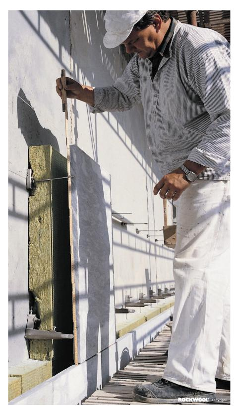
менно улучшить теплотехнические характеристики ограждающей конструкции как при реконструкции старых зданий, так и при возведении новых. Кроме того, поскольку при монтажных работах все так называемые «мокрые» процессы исключены пол-
