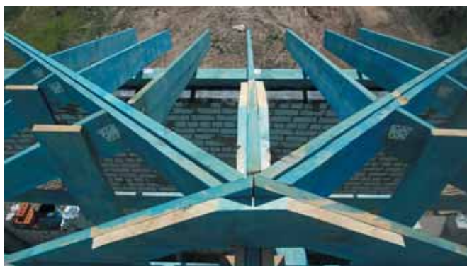
Рис. 4. Узел конькового прогона на вальме – одинарная стропильная нога с двумя накладными элементами (вид сверху)
