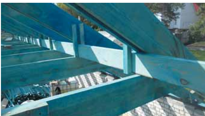
Рис. 8. Консольный прогон из двух досок сечением 150х25 мм
