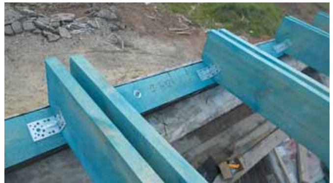
Рис. 11. Узел опирания составных стропильных ног на мауэрлат
