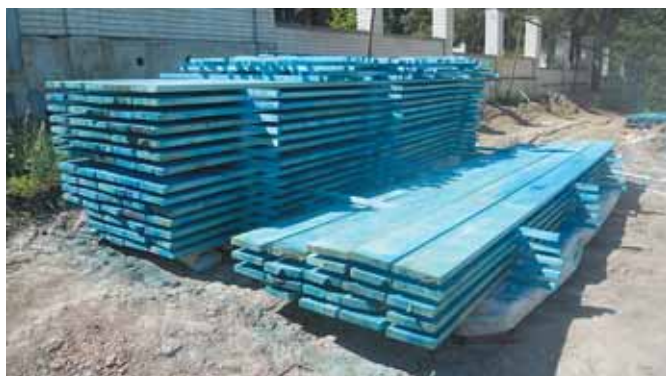
Рис. 1. Обработка антисептиком обрезного пиломатериала с добавлением красящего состава
