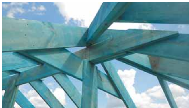
Рис. 3. Узел конькового прогона на вальме – одинарная стропильная нога с двумя накладными элементами (вид снизу)
