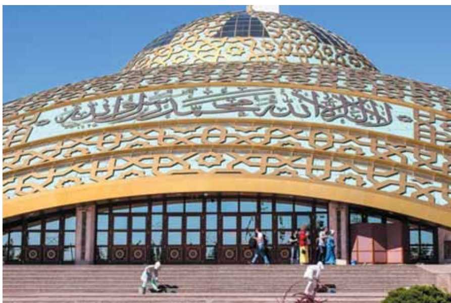
Орнамент на фасадах и куполе мечети выполнен из анодированного алюминия. Фото: Kalzip
