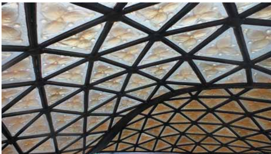
Инновационная техническая разработка нового материала студии Павла Оринянского – это изогнутая полупрозрачная кристаллическая фактурная стеклянная структура внутри стального каркаса усиленного множеством ребер жесткости реализована по технологии diagrid (диагонально-решетчатая конструкция).
