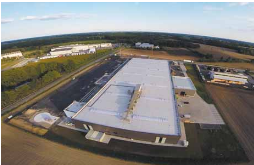
В связи с повышением спроса на интеллектуальные системы организации контроля доступа Winkhaus строит новое производство. Фото: Winkhaus
