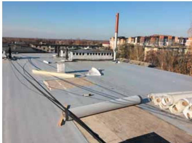
пользовании клеевого метода с полной заменой технологии наплавления и материалов на современные, основанные на инновационных полимерных решениях LOGICROOF. Такого рода клеевые кровельные системы можно применять на основаниях, не допускающих механическую фиксацию и на крышах любых сложных конфигураций – они гарантируют высокую эксплуатационную надежность, включая высокое сопротивление на отрыв при ветровых нагрузках.
