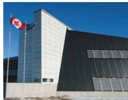
Здание с установленной системой SolarWall
