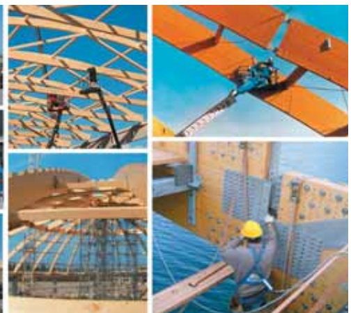
Транспортировка и монтаж деревянных клееных конструкций
