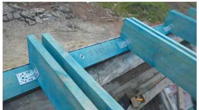
Рис. 11. Узел опирания составных стропильных ног на мауэрлат
