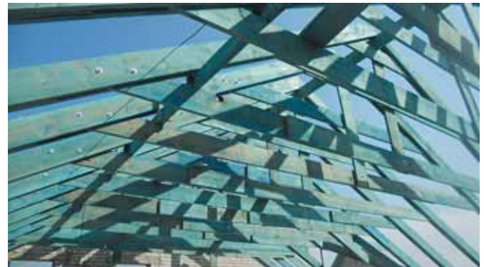
Рис. 10. Общий вид накосных одинарных ног и конькового прогона из досок сечением 250х40 мм
