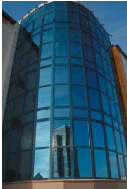
Сплошное ленточное остекление фасадов, балконов и лоджий можно тянуть на высоту до 30 м
