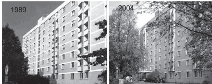
Рис. 6. Западный фасад объекта 16 (Дом престарелых в Мюнхене) в сентябре 1989 г., через 3 года после применения СФТК, и в ноябре 2004 г., спустя 15 лет.
