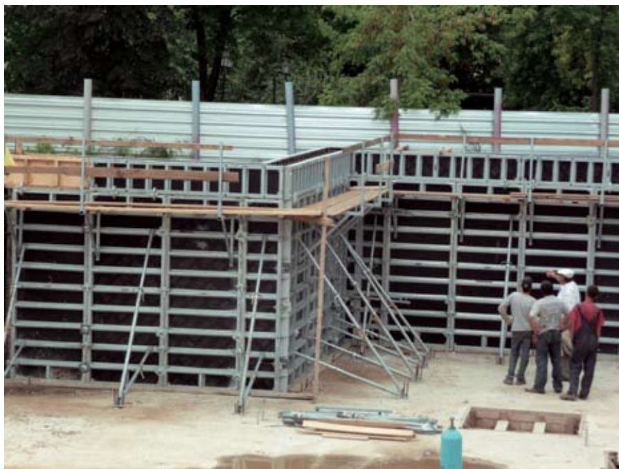
Рис. 2. Крупнощитовая модульная стальная опалубка AGS-M-80St.
