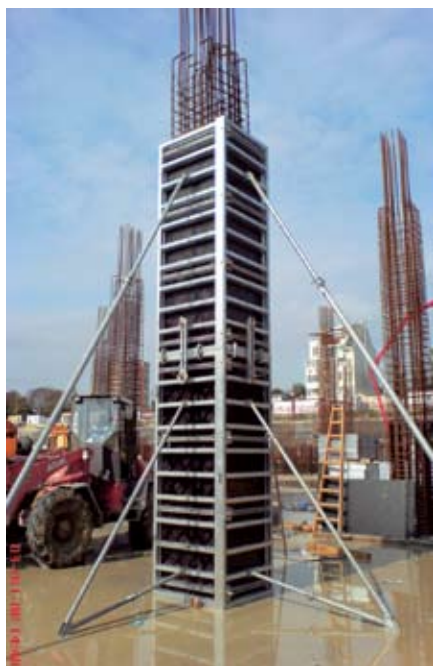
Рис.1. Крупнощитовая модульная алюминиевая опалубка AGS-80AL
