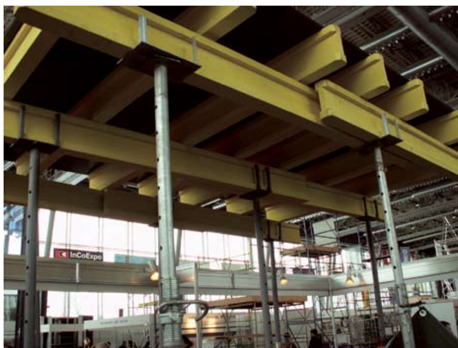
Рис.3. Опалубка перекрытий «Высота» (AGS — AL-100)
