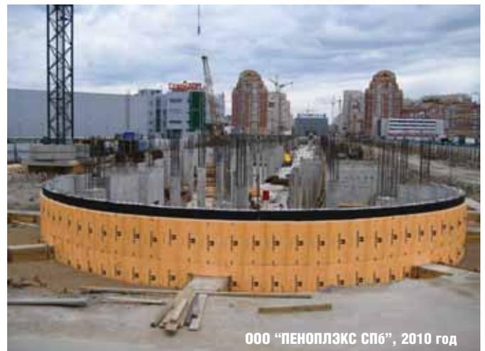
службы фундамента. Плиты ПЕНОПЛЭКС® являются оптимальным решением для утепления фундамента благодаря минимальному водопоглощению, высокой механической прочности, низким коэффициентом теплопроводности, стабильностью теплофизических свойств и долговечностью свыше 50 лет.
