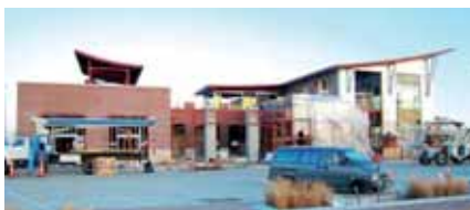
Процесс выполнения работ на здании Палаты общин
