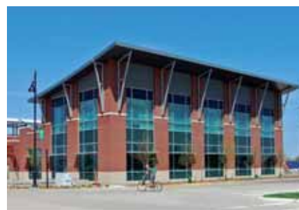
На вогнутой части кровли была использована ПВХ система
