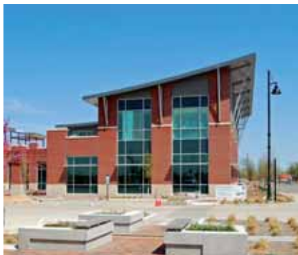
Часть завершенной кровельной системы
